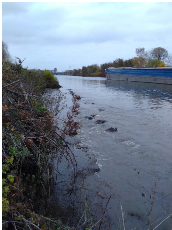
Figure 5. Dégradation complète du système de protection géosynthétique entraînant un recul très important de la berge
